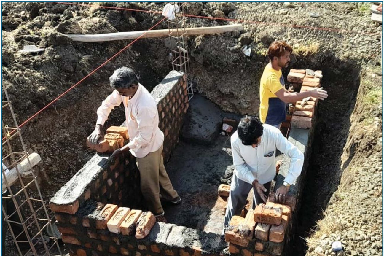
सेप्टिक टैंक निर्माण के विषय पर राज मिस्त्रियों का प्रशिक्षण, पीथमपुर
