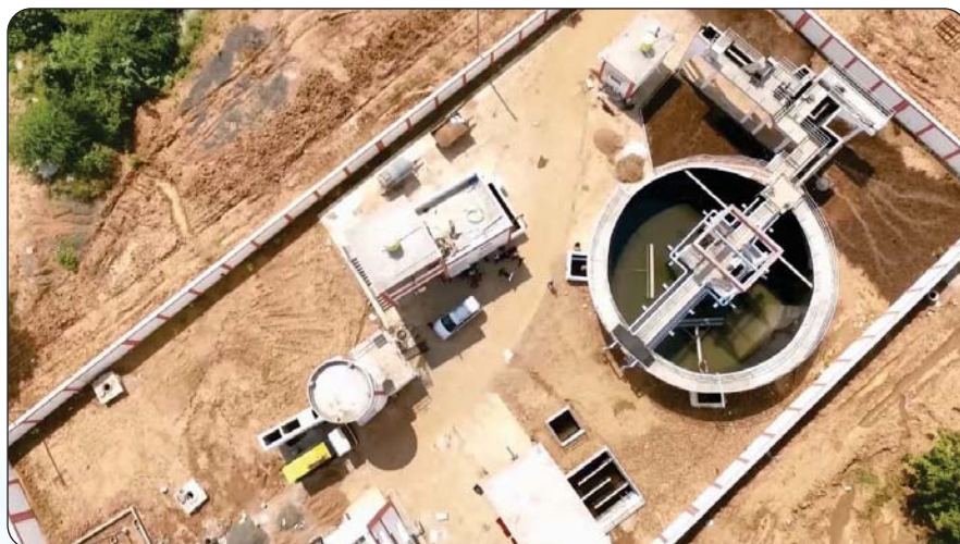
Image: बुदनी, सीहोर जिले में निर्मित 2.2 एमएलडी सीवरेज ट्रीटमेंट प्लांट
