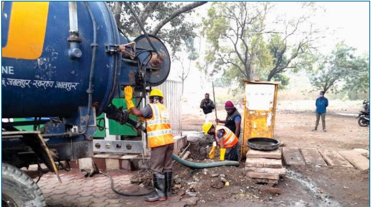
सीवर लाइन की सफाई कर्मियों के द्वारा मशीनीकृत सफाई, जबलपुर
